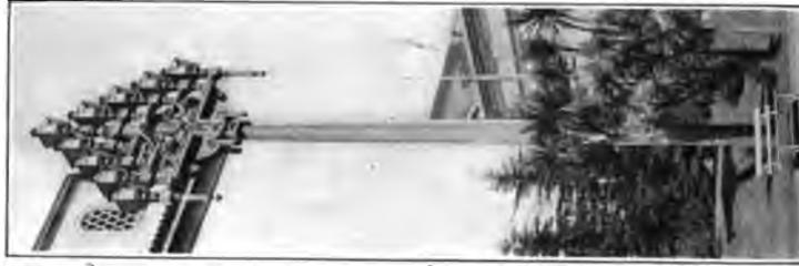
FIG. 30—NINE-LIGHT LUMINOUS ARC STANDARD, HEIGHT 35 FEET
