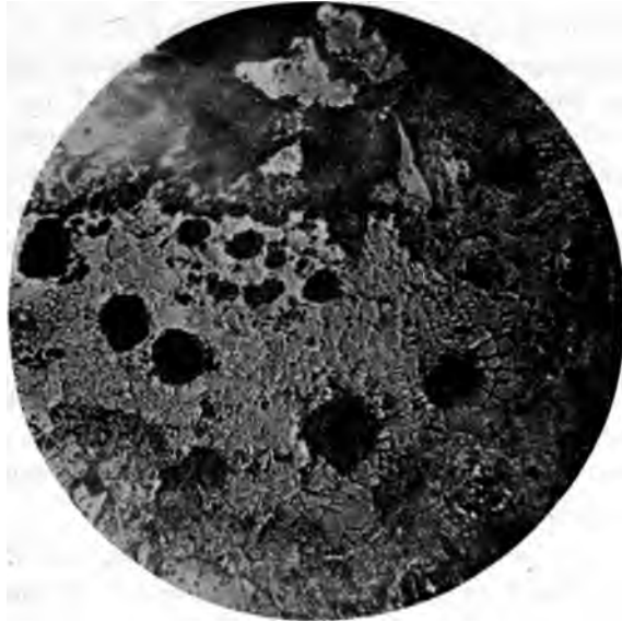
FIG. 10 CONCRETE FROM PIER 2, HALIFAX, N. S.
