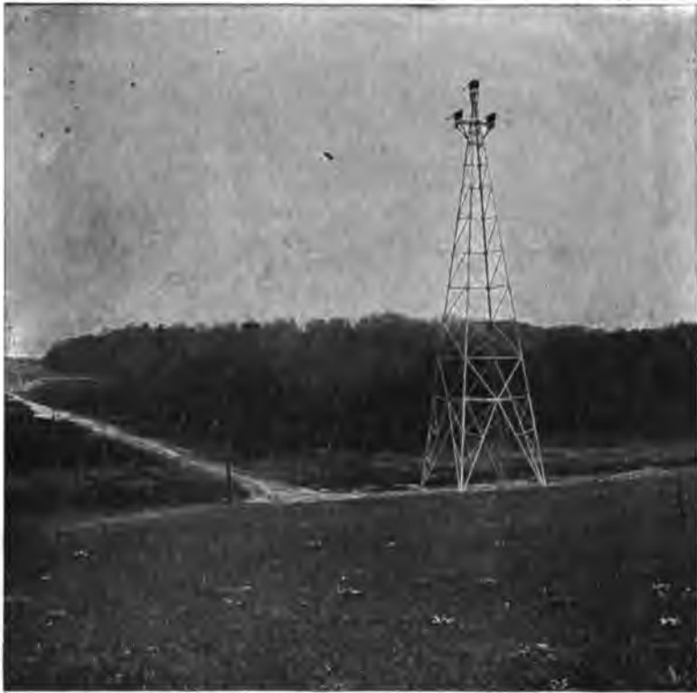
FIG. 8—1253-foot span over swamp
