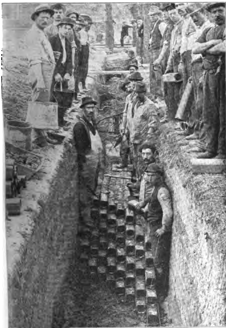
Fig. 97. The Separate Duct Terra-Cotta Conduit.
