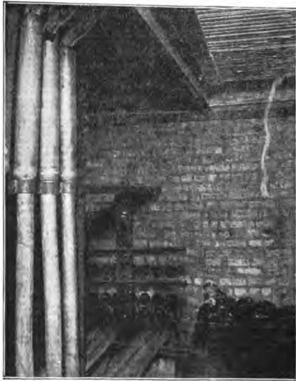
Fig. 112. A Terminal Manhole.
