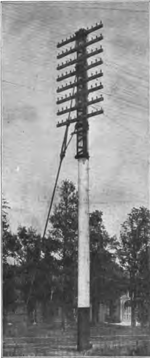
Fig. 20. Composite Anchor Pole.
