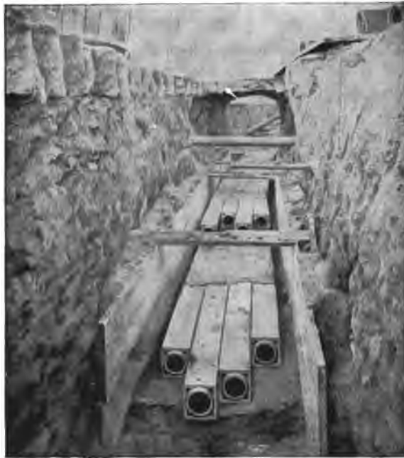
Fig. 223. Terra-Cotta Conduit under Construction.
